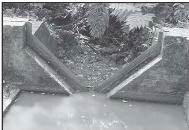
Figura 3. Vertedor triangular.
