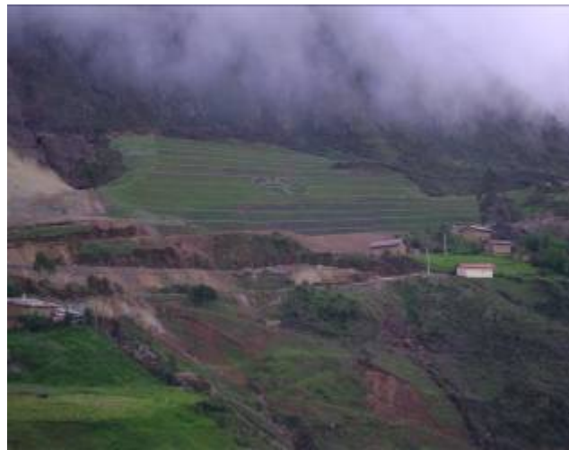
Figura 4 Vista del pasivo rehabilitado Febrero 2010
